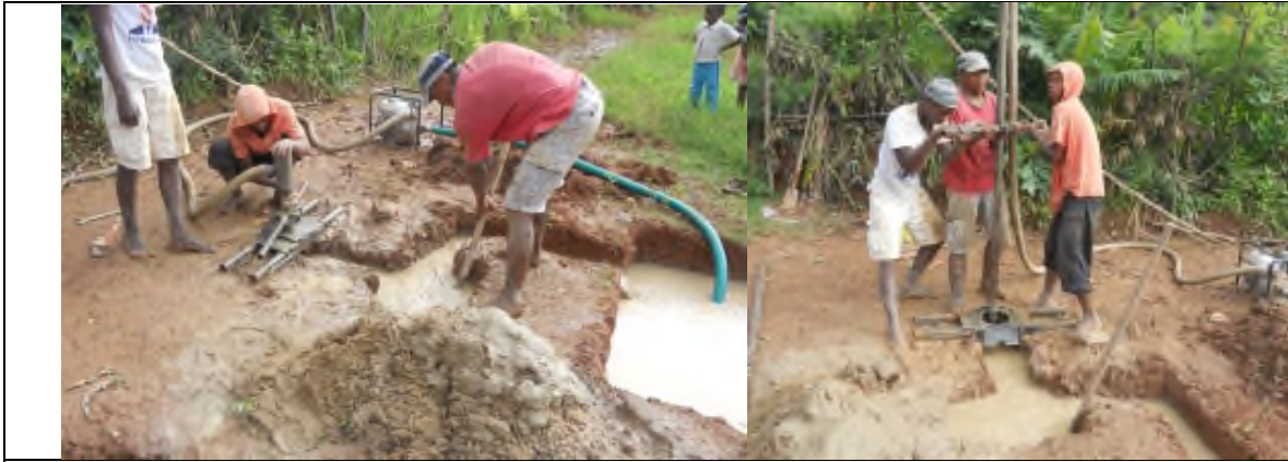
Photo 01 : Les équipes en plein construction de forage
