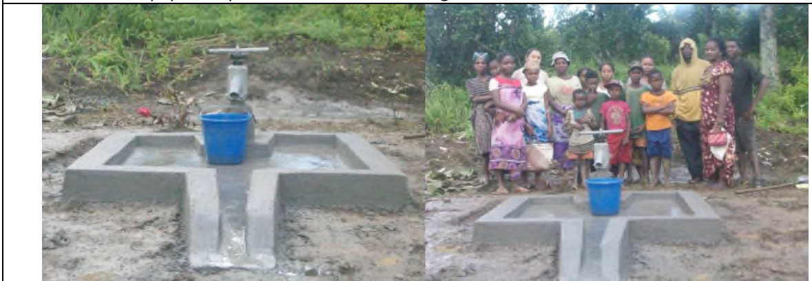
Photo 02 : Le lendemain de la construction de dalle d'assainissement
